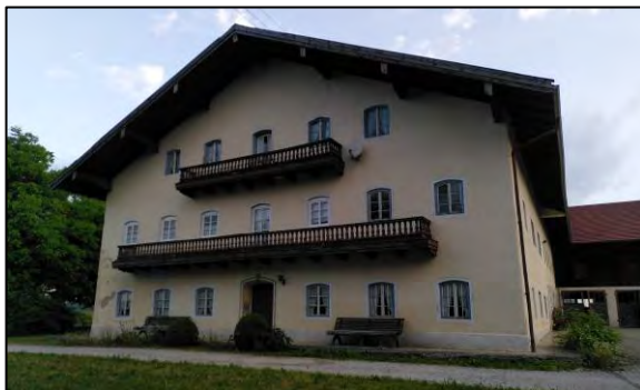
Abbildung 22: Südseite des Hauptgebäudes im Süden des Plangebietes in der Gemeinde Amerang; Blick in Richtung Norden (Mühl 06.05.2021)
